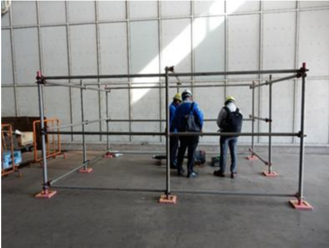
① 遮蔽シート取付けフレームを設置する
